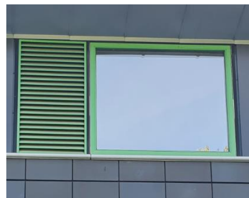
Vindue på 1. sal der skiftes
